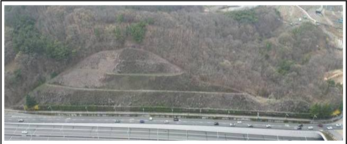
현 황 삼덕대절토사면 좌측 전경
