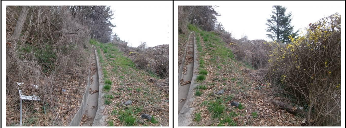
위 치 산마루측구 위 치 하부 전경 내 용 - 내 용 -
